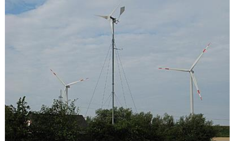
25924 Klanxbüll S&W 7.5, Inbetriebnahme Oktober 2013
