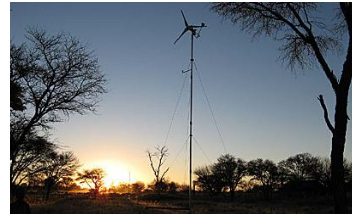
Namibia / Rehoboth S&W 2.0, Inbetriebnahme September 2012
