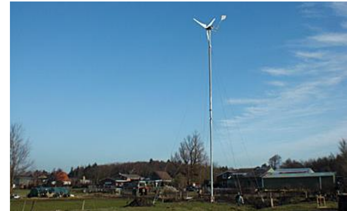
Dithmarschen / Krempel S&W 5.5 auf 22m Mast, Inbetriebnahme April 2011
