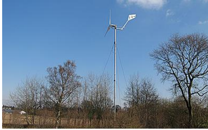
Kreis Bad Segeberg / 23867 Sülfeld S&W 20.0, Inbetriebnahme April 2012
