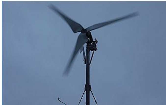
Dithmarschen / 25774 Rehm S&W 15.0, Inbetriebnahme November 2012
