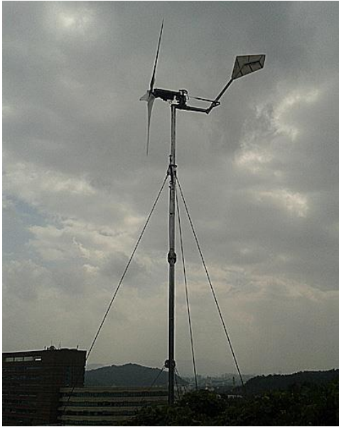
Korea Advanced Institute of Science and Technology / Daejeon, Südkorea S&W 5.5, Inbetriebnahme September 2014
