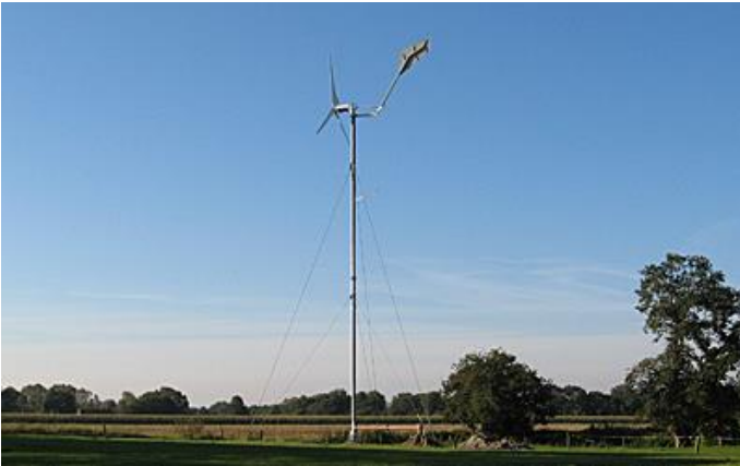
26871 Aschendorf S&W 15.0, Inbetriebnahme Oktober 2013
