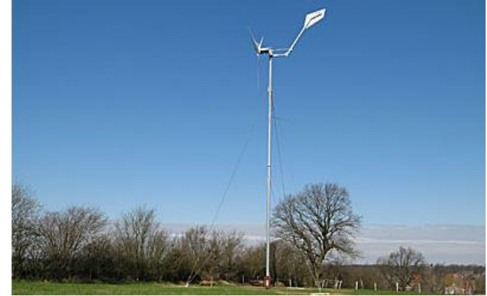
Kreis Bad Segeberg / 23795 Mözen S&W 20.0, Inbetriebnahme April 2012
