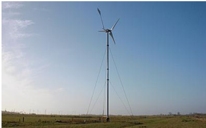
Dithmarschen / Krempel S&W 15.0 auf 24m Mast, Inbetriebnahme Dezember 2010
